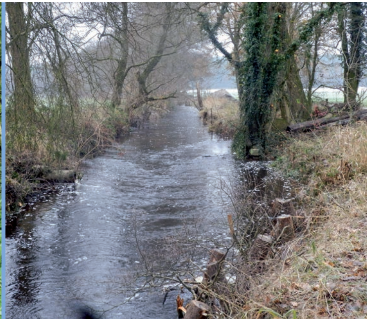
Vorher/Nachher! Das Wehr mit seiner Bodenplatte wurde fast komplett ausgebaut. Auf der linken Seite (in Fließrichtung gesehen) blieb ein Teil erhalten und damit auch der Kolk. Jetzt erinnern nur noch einzelne Reststeine am Ufer (rechtes Bild) an das frühere Wehr.
