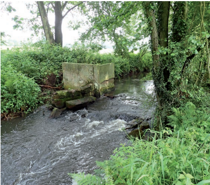
Vorher/Nachher! Das Wehr mit seiner Bodenplatte wurde fast komplett ausgebaut. Auf der linken Seite (in Fließrichtung gesehen) blieb ein Teil erhalten und damit auch der Kolk. Jetzt erinnern nur noch einzelne Reststeine am Ufer (rechtes Bild) an das frühere Wehr.
