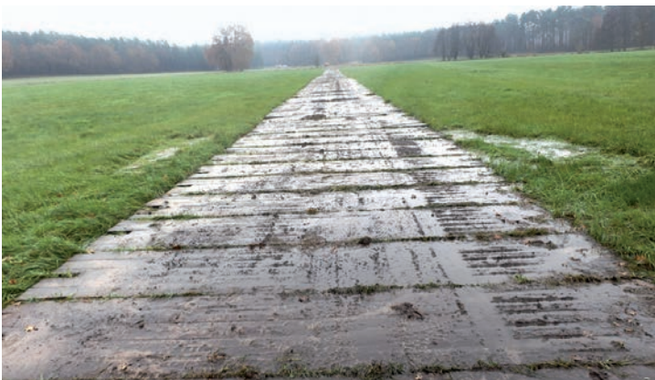
Eine lange Baustraße musste gelegt werden, aber es hat sich gelohnt, das Grünland wurde hier nur gering beeinträchtigt.
