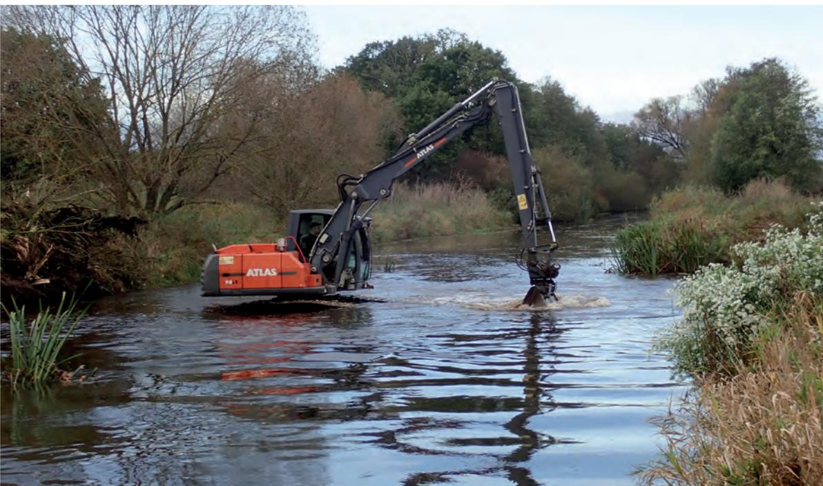
Zur Anlage der Kiesbänke musste der Bagger aufgrund der Breite der Aller ins Gewässer fahren.
