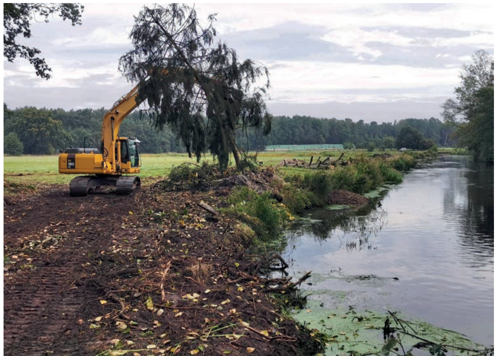
Auch Bäume, die für die Baumaßnahme weichen mussten, wurden als Raubbaum in die Böhme eingebaut (Foto: Hinnerk Voermanek).
